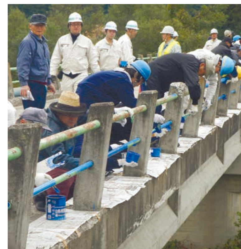
〈住民と学生との協働による橋の欄干塗装〉
